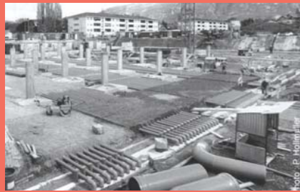
Puits canadien à la Cité solaire de Plan-les-Ouates (Suisse)
