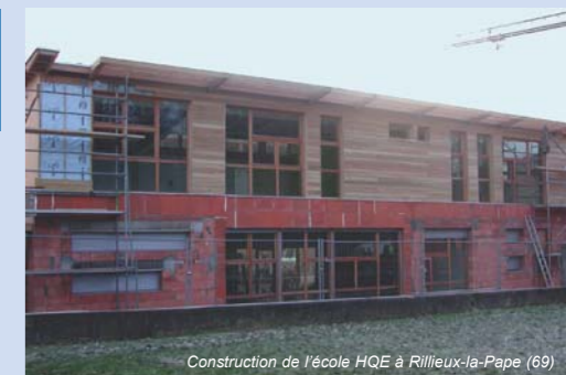
Construction de l'école HQE à Rillieux-la-Pape (69)
