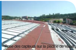
Pose des capteurs sur la piscine de Vaise
